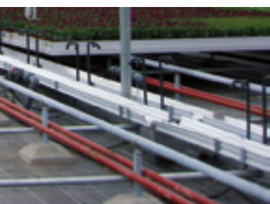
Stütze mit Betonsockel
